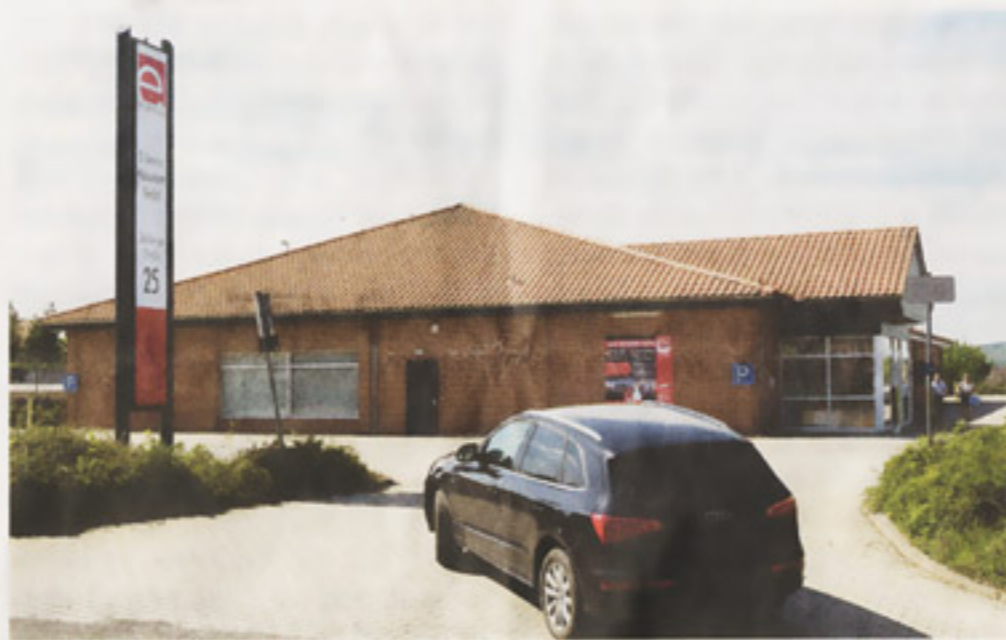
Den früheren Edeka-Markt hat das Unternehmen zu Büroräumen und einer Werkstatt ausgebaut.
